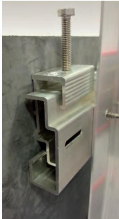
La estructura se compone de perfiles y grapas. Dichas grapas se fijan sobre el soporte existente, por medio de tacos de dimensiones oportunas y aptas para dicho soporte. Sobre los perfiles montantes se fijarán posteriormente los perfiles horizontales, sobre los que se colgarán las piezas **DEKTON**.
